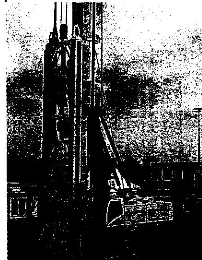
Hình A.3.2 Gầu ngoạm dùng để thi công tường trong đất, có thể được treo tự do trên cáp hoặc được dẫn theo một khung dẫn hướng, đóng mở gầu bằng thủy lực hoặc bằng cáp.
